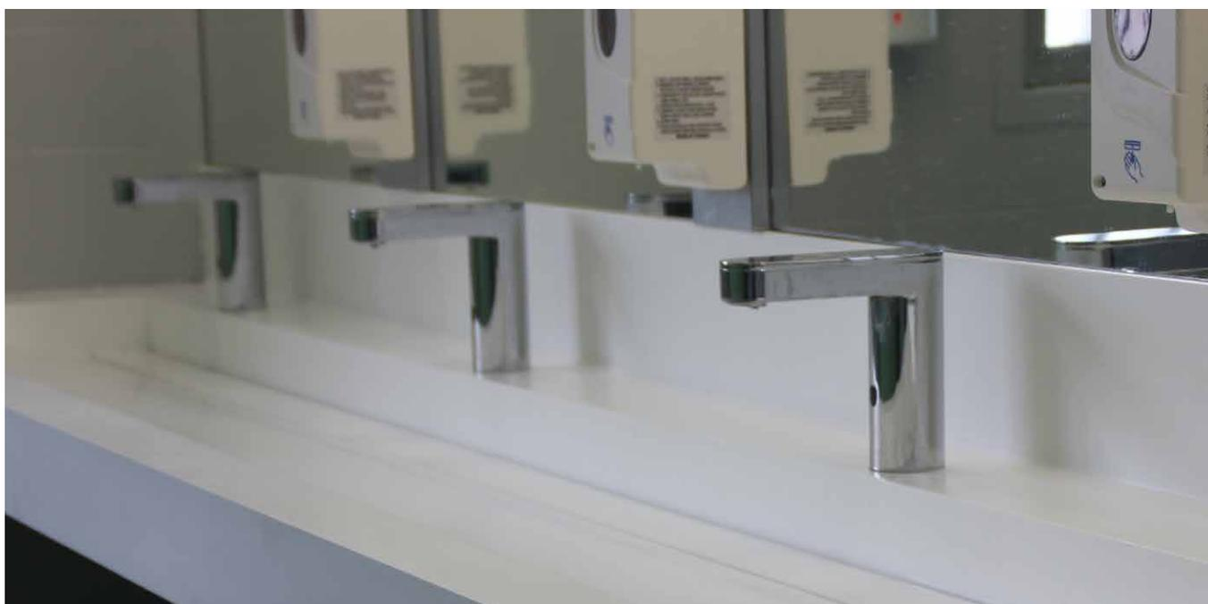
*Exemple de robinets à capteurs, idéal dans une situation de potentiel vandalisme*
