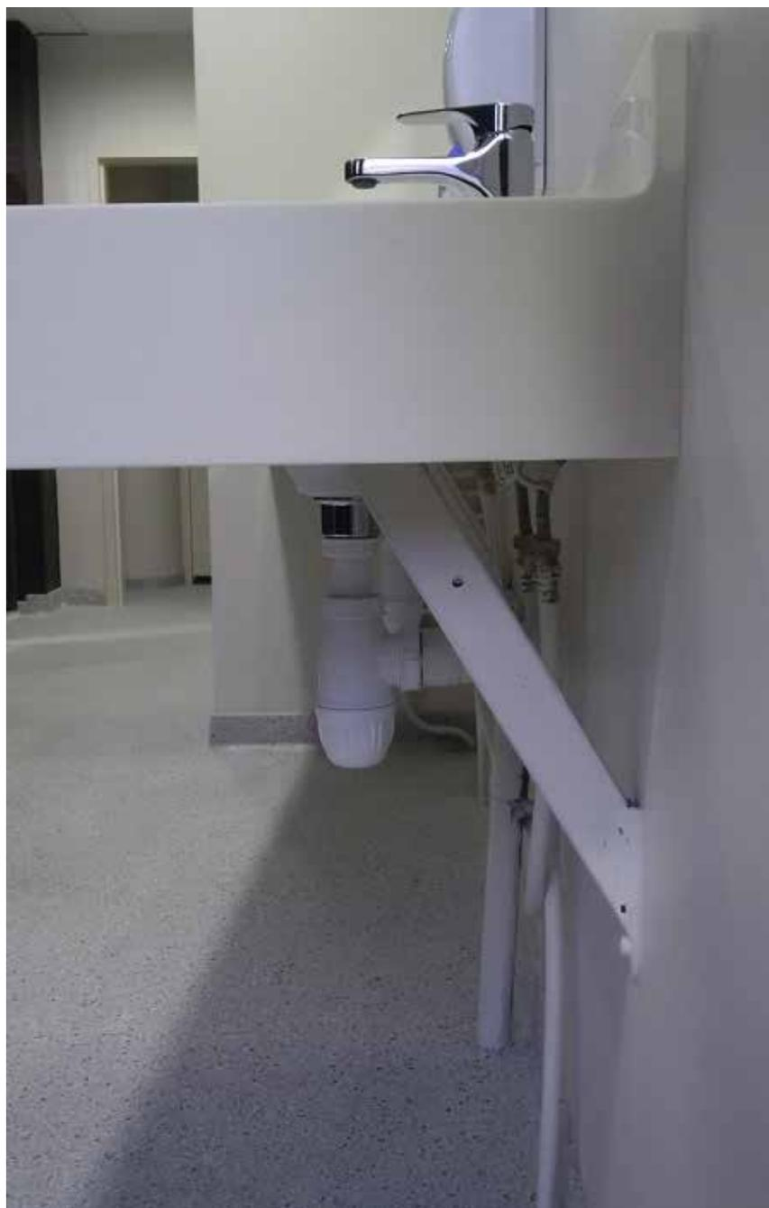
L'absence de montant vertical permet une fixation au mur sans avoir à déplacer les canalisations existantes. Conforme aux normes d'accessibilité
