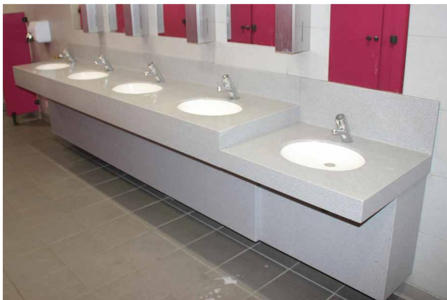
*Ce plan vasque ainsi que cette vasque & table à langer sont aux normes PMR (Personnes à Mobilité Réduite). L'ajout d'une vasque à faible profondeur, le rabaissement d'une partie du plan de travail, et la profondeur accrue du plan de travail assurent une accessibilité facilitée.*
