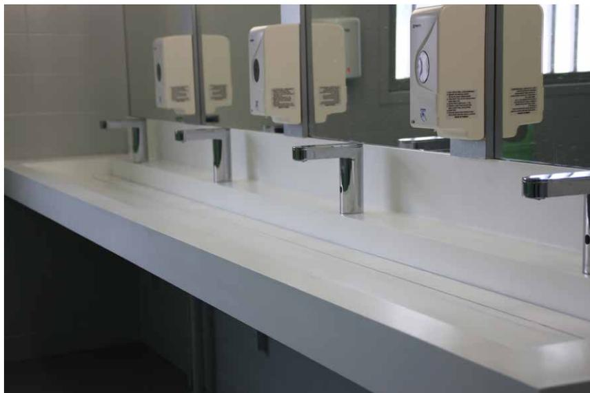
*Ce système de vasque ouverte sur le devant utilise une conception de rigole d'écoulement à la place d'un drain traditionnel rond.*
